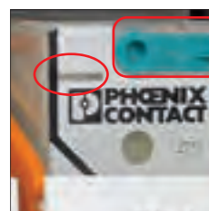
接點側標示與測試拉桿
